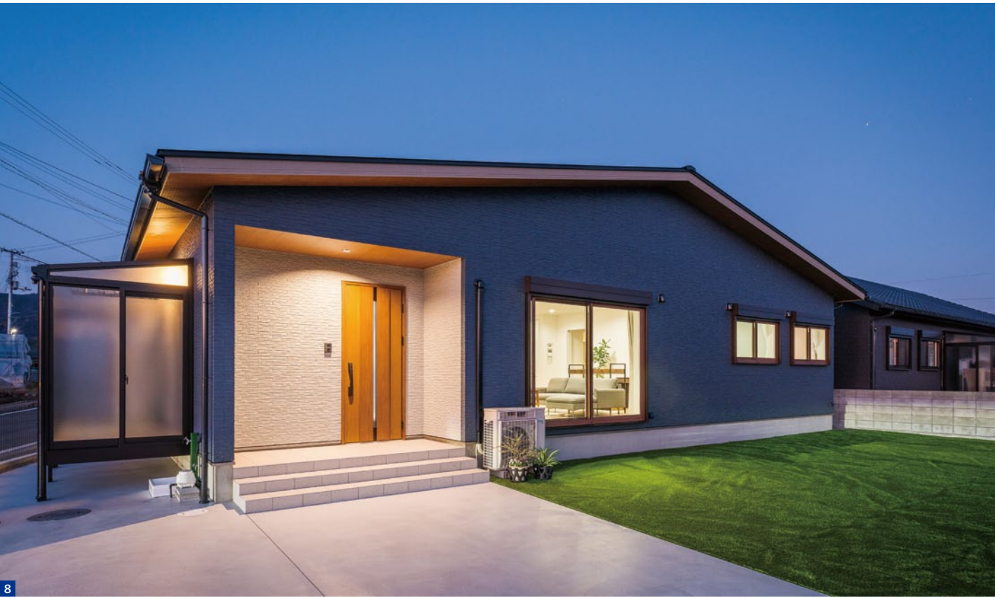
4洗面・ランドリールームは、横長の広々スペース。作業カウンターの上部に昇降式の物干しを設置し、空間の有効活用を図っています。5洗面・ランドリールームから、クロークヘー直線につながる、スムーズな家事動線計画となっています。6トイレ背面のデッドスペースを利用し、コンパクトな収納ボックスを設けました。壁紙の色柄を変えて空間にアクセントを与えています。7ブルーとライトグレーの爽やかな組み合わせに、木目調のサッシの差し色が、外観全体を引き締めています。8前庭を人工芝と土間コンクリートのシンブルな組み合わせに。使い勝手に配慮しつつ、外観になじむ色合いとしました。
