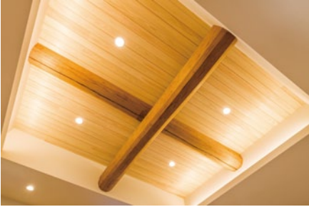
先代が残した建物の丸太部分を、リビング中央の化粧梁として生かしました。
