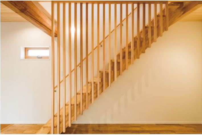
既存丸太に合わせて、木製階段としました。スリット階段と縦格子を採用することで、重くなりがちな階段部分を軽やかに表現しています。
