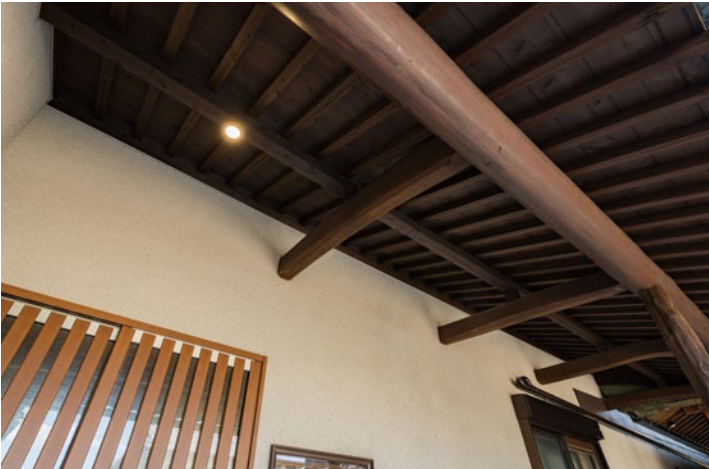
経年変化で古く色褪せていた軒裏。既存そのものを、塗装技術によって落ち着いた高級感のある木の風合いに一新しました。
